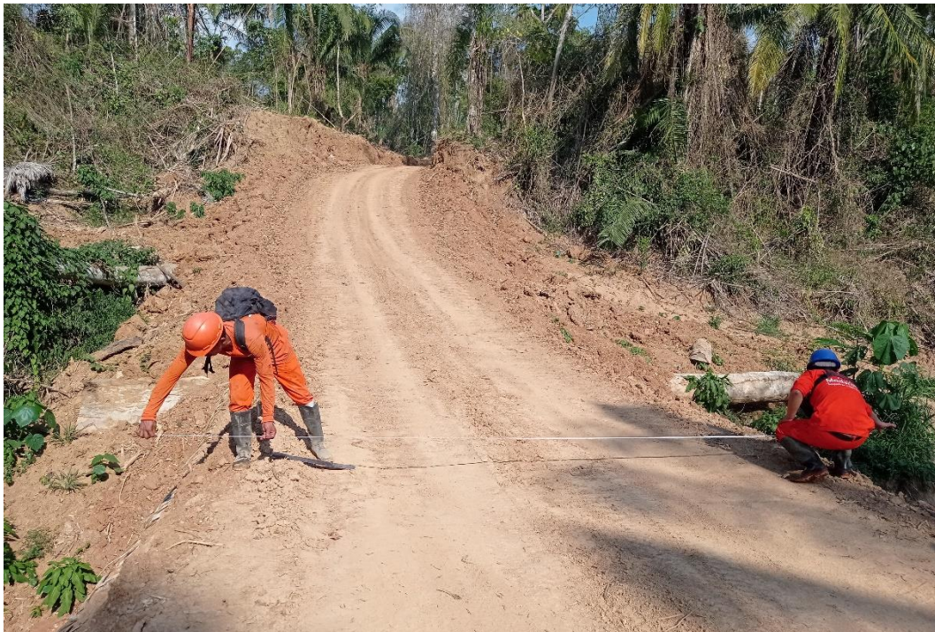
Figura 21. Medición del ancho del puente N°2 en la PC 18.
