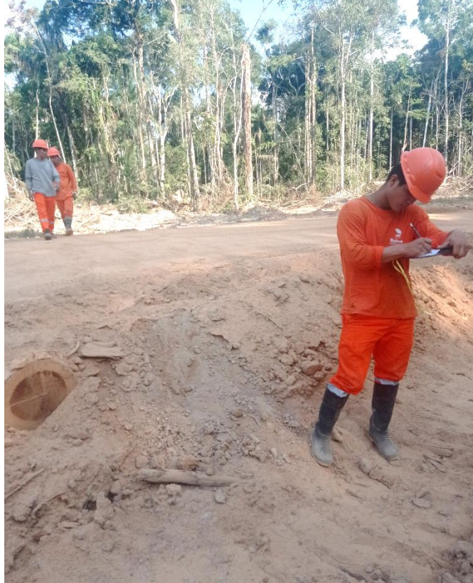
Figura 22. Evaluación cualitativa de la construcción de alcantarillas en la PC 18.
