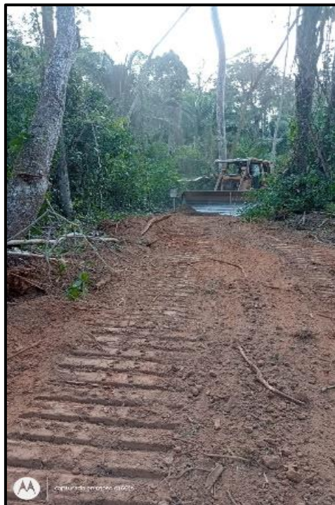
Figura 2. Mantenimiento de franja rompe fuego entre el V5-V6 "Sector Shingo" . Fuente: Maderacre, 2024.
